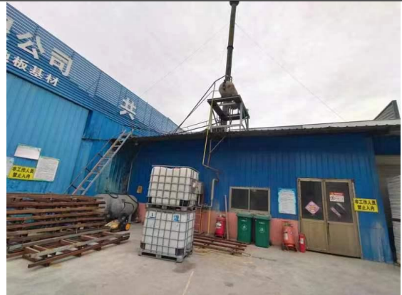
锅炉排气筒 P3
