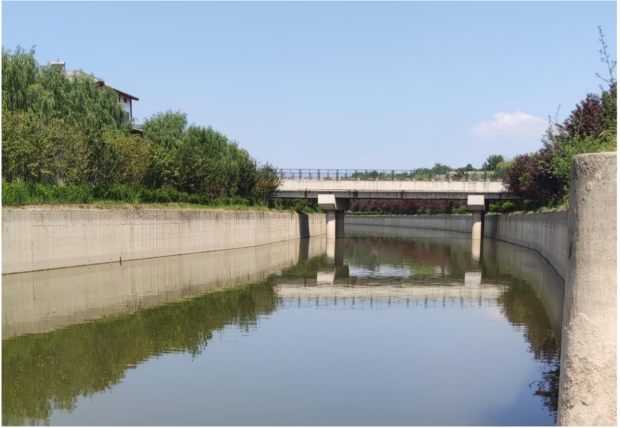
照片编号 HJ001-P005 拍摄对象名称 小运河 拍摄时间 2023. 08. 30 拍摄内容说明 小运河河道及水面治理情况
