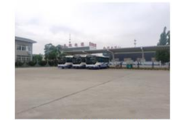
阳谷县石佛镇客运站充电站
