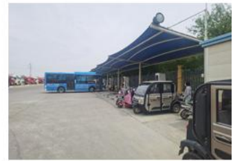
阳谷县丰源公交有限公司南站充电站
