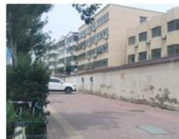
阳谷县供电公司检修工区有序专用充电站
